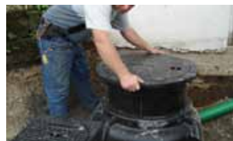
8a.) TOPATEC Teleskopschachtaufsatz einsetzen (bis Klasse B125)
