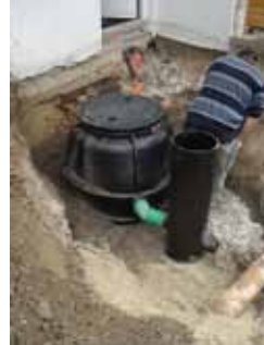
5.) Probennahmeschacht setzen und anschließen
