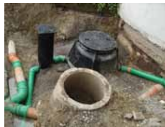
6.) Abwasserrohr wasserdicht anschließen
