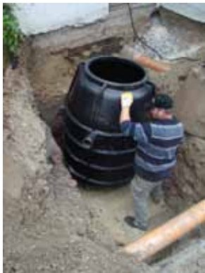
2.) Fettabscheider einsetzen
